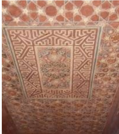
(صورة ٤٠): سقف خشبي من احد بيوت رشيد- حفرتولوين المشاكل والمعوقات التي تواجه القائمين على النجارة الاسلامية :
